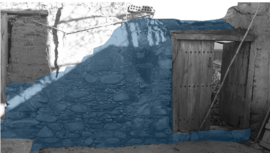
Πέτρινοι τοίχοι ακατεργαστης πέτρας/ χωρίς επίχρισμα
