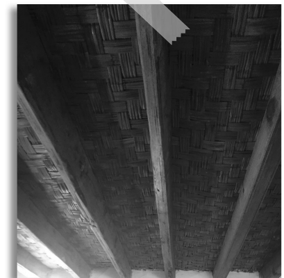
Υλικότητα οροφών από πλεκτά καλάμια και ξύλινους δοκούς
